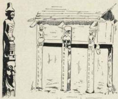
Abb. 142. Vorbau eines Dajaks-Hauses in Kasungan.
