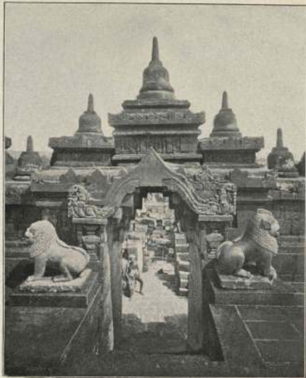
Abb. 126. Tor mit Singha's von der höchsten nördlichen Galerie-Mauer des Borobudur.
